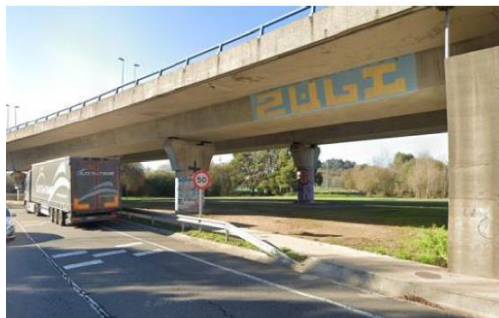
P.Q. 1+400 Conexión con sendas do río Lagares e Samil. Estreitamento a ampliar.
